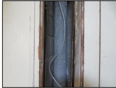
Photo N° 1071 AMIANTE CIMENT -- PLACARDS TECHNIQUES -1 à +4 Conduits de fluide Chute E.P.(Fibres- ciment)
